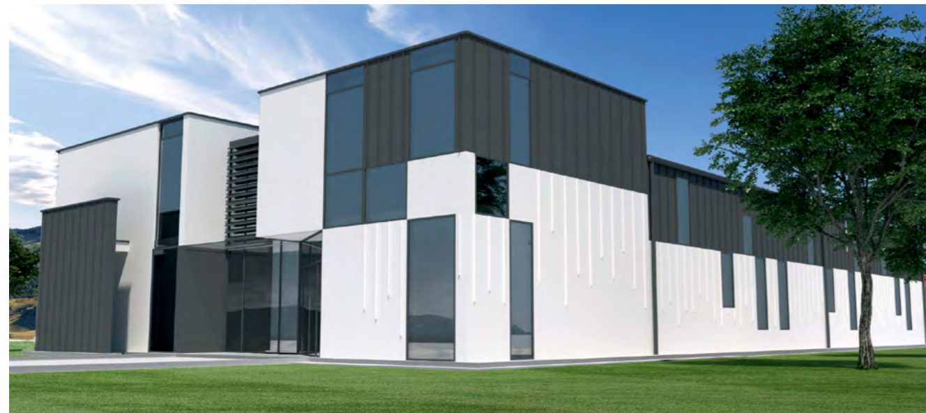
Budynek usługowo-przemysłowy: elewacja z użyciem listwy BP19 ozdobnej „na rąbek”.
